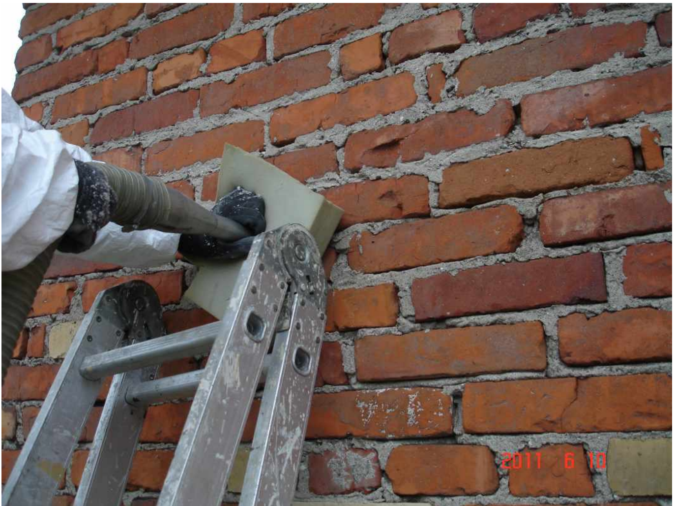
Dokumentacja fotograficzna wykonania usługi ocieplenia ścian (wdmuchiwanie celulozy w przestrzeń dylatacyjną).
